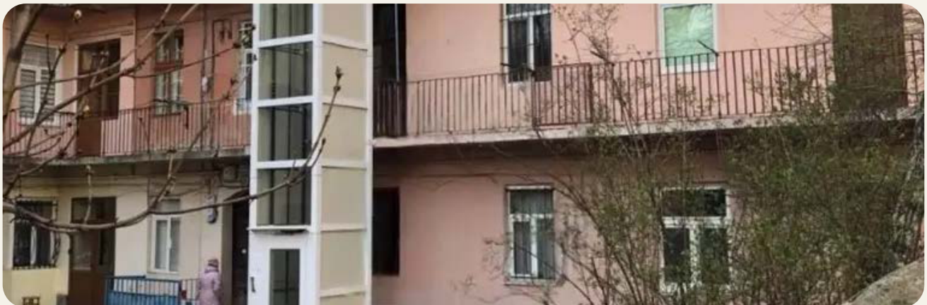
Рисунок 1.33. Приклад прибудови ліфта до галереїного будинку
