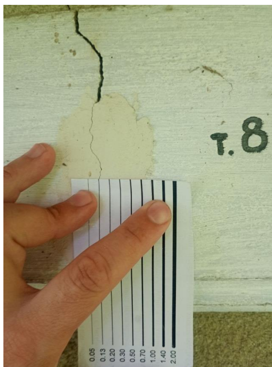
Рисунок 4.7 – Результати фотофіксації розкриття гіпсових маяків на будівлі №144 у 2025 р.
