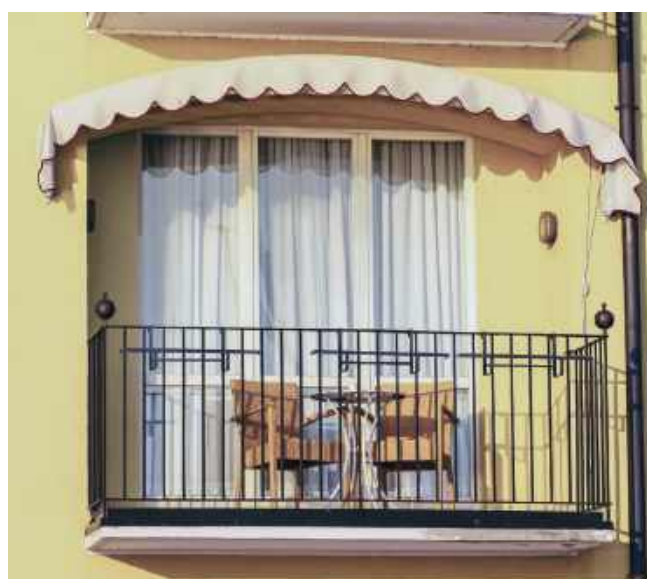
Опорядження балкона • © Shebeko
