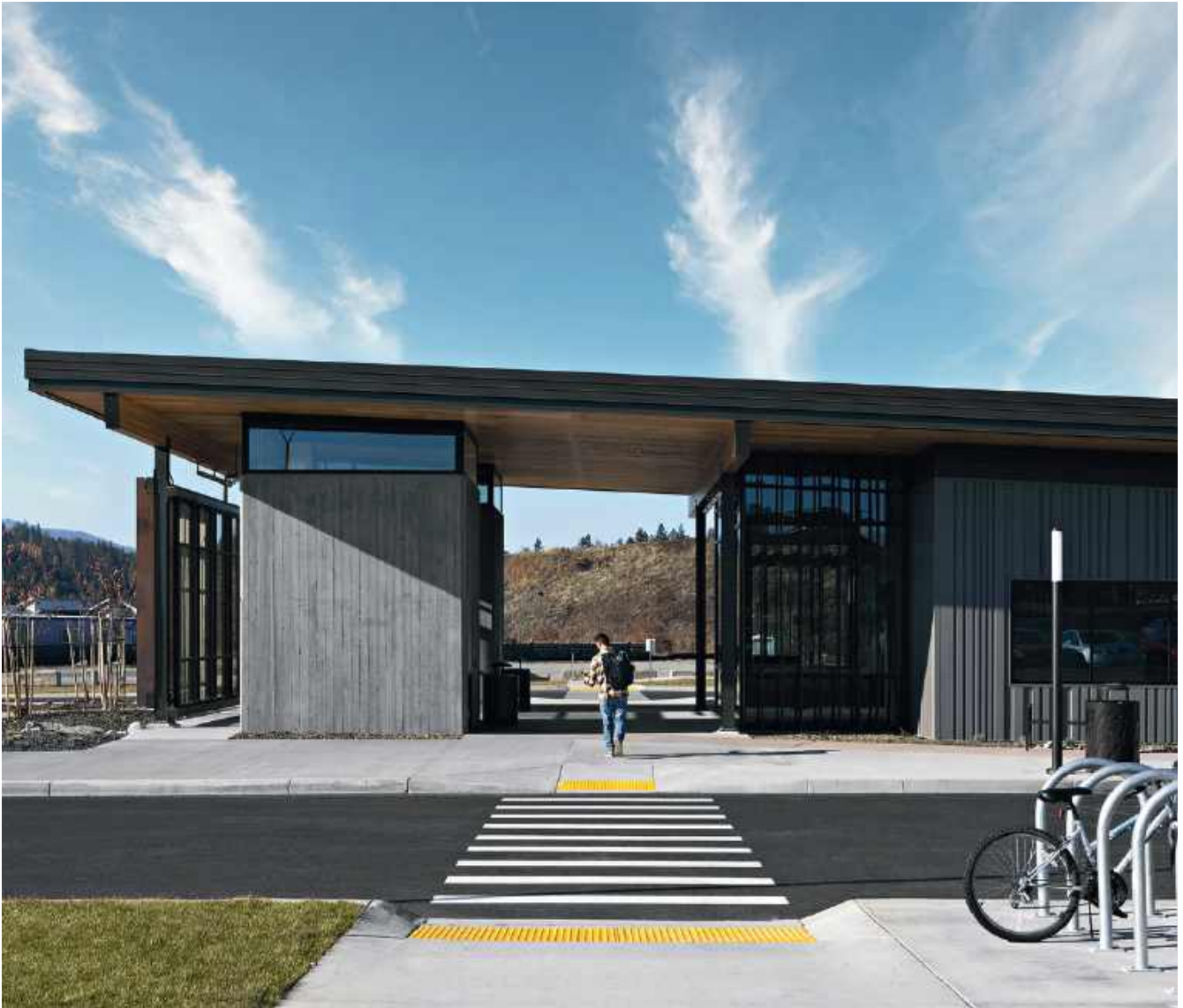
Будівлі для додаткових послуг, США • © Tony Roslund Photography
