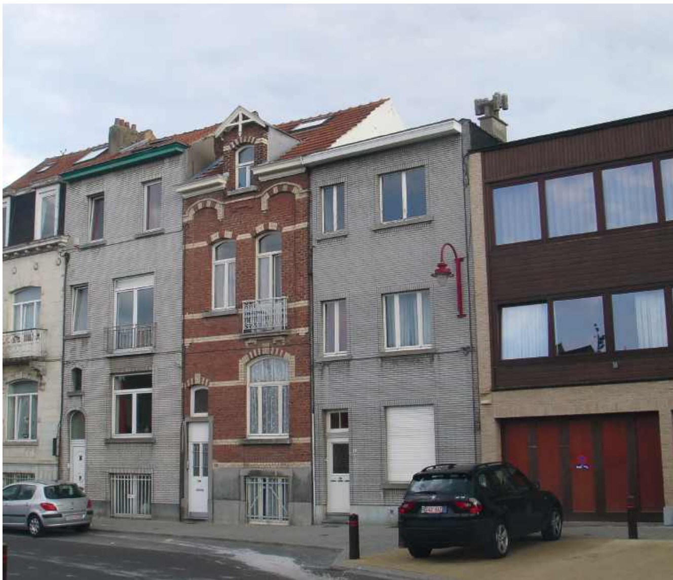
Реконструкція будівлі в Брюсселі, Бельгія • © bakalaerozzphotography
