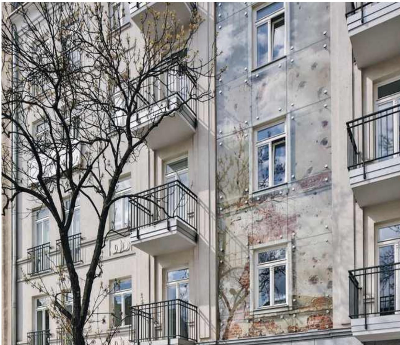
Оновлення фасаду, Польща • © Bartosz Makowski
