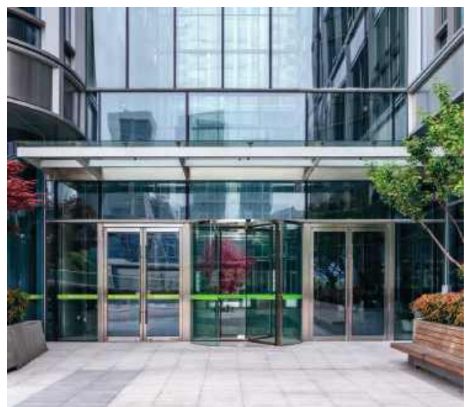
Вхід врівень з покриттям в Китаї • © 4045qd
