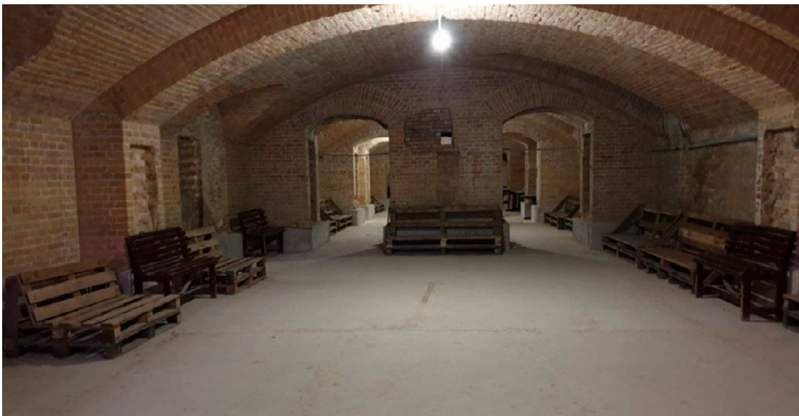
Рис. 20. Підвальне приміщення двоповерхового будинку у місті Кропивницькому
