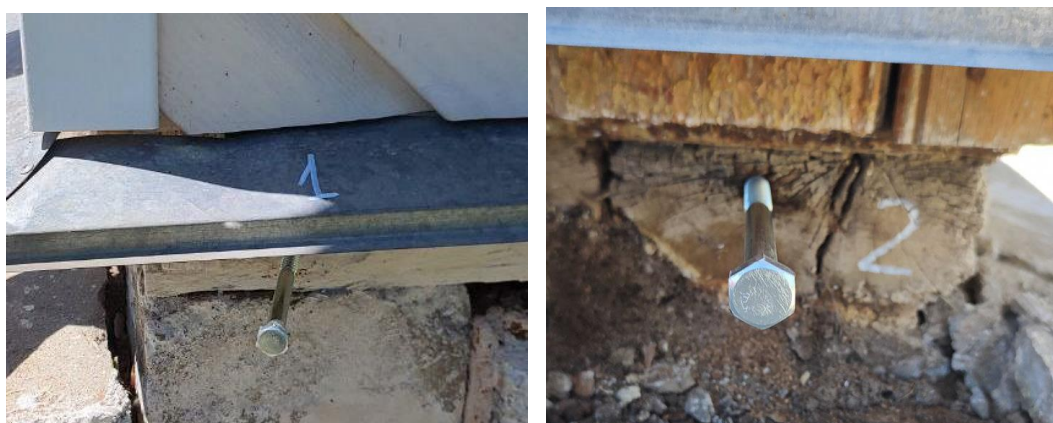
Рисунок 3.11 – Зображення реперів у будівлі №84
