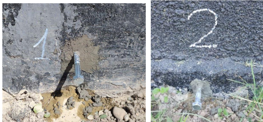
Рисунок 3.10 – Зображення реперів у будівлі №196
