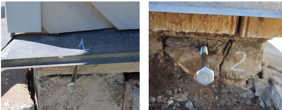
Рисунок 2.12 – Зображення реперів у будівлі № 84
