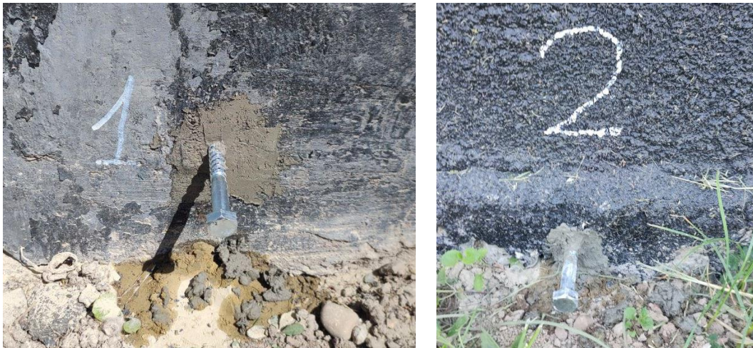
Рисунок 2.11 – Зображення реперів у будівлі №196
