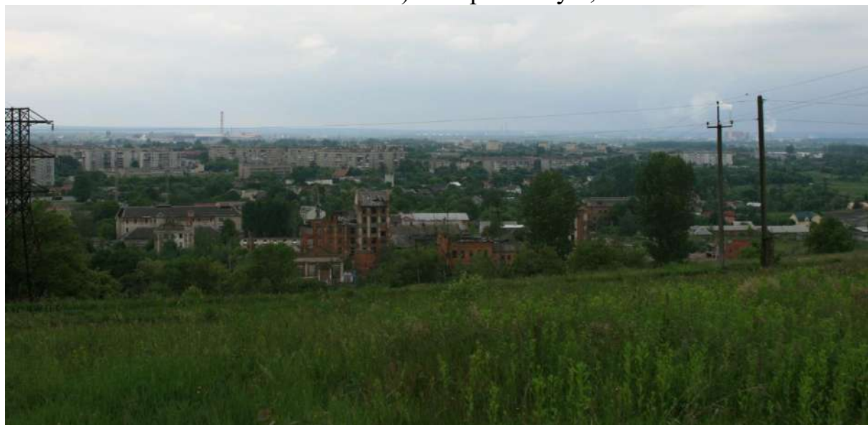
44-52. Комплекс (Калуського) калійного комбінату, кін. 19-поч. 20 ст. (охор. №№ 1225-1228). Фабрична вул., 6-12
